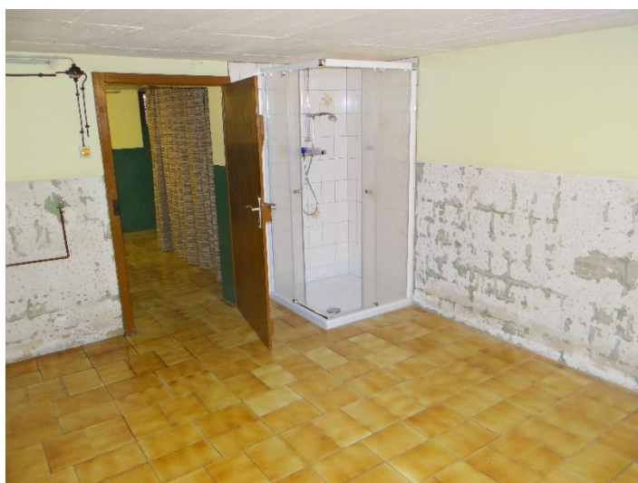
Waschküche mit neuer Dusche
